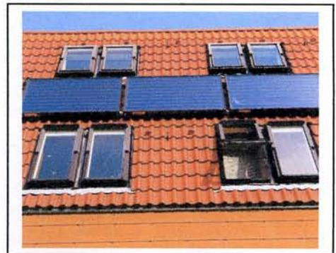
Bei großen Dachflächen wäre ein Konzept mit zusätzlicher Heizungsunterstützung möglich bzw. sinnvoll.
